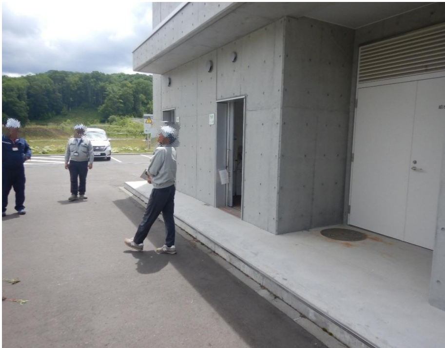
[平取ダム・トイレ設備]
