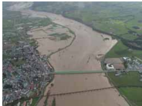
写真 1-2-6 平成 15 年 8 月洪水 富川地区浸水状況(下流から望む)
