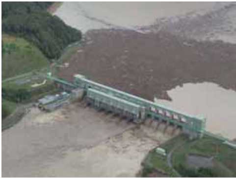
写真 1-2-5 平成 15 年 8 月洪水 二風谷ダム洪水調節状況(下流から)
