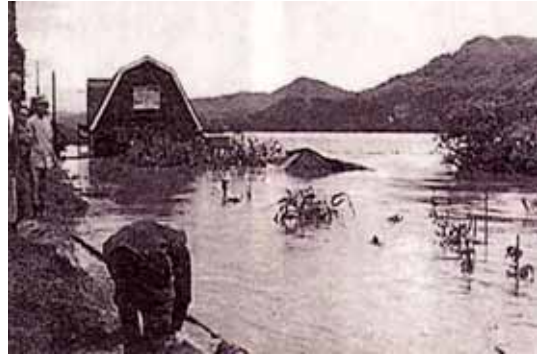
写真 1-2-2 昭和 37 年 8 月 4 日洪水 平取町沙流川右岸浸水倒壊家屋
