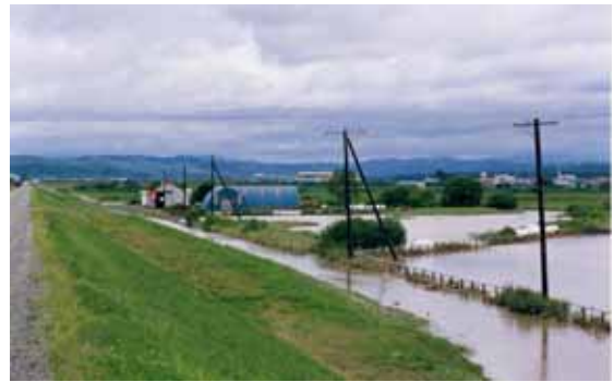
写真 1-2-4 平成 4 年 8 月 9 日洪水 河口左岸内水氾濫状況
