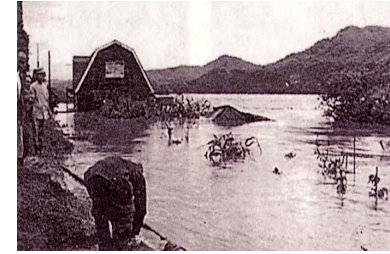
写真 1-2-2 昭和 37 年 8 月 4 日洪水 平取町沙流川右岸浸水倒壊家屋
