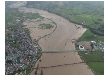
写真 1-2-6 平成 15 年 8 月洪水 富川地区浸水状況(下流から望む)
