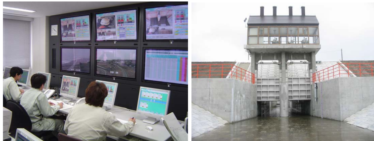
写真 2-1-2 樋門樋管改築 遠隔操作化イメージ写真
