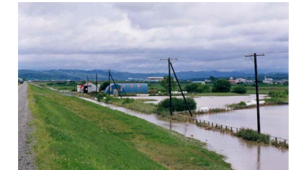
写真 1-2-4 平成 4 年 8 月 9 日洪水 河口左岸内水氾濫状況
