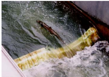
写真1-2-11 二風谷ダム魚道 をのぼるサケ
