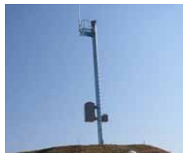
監視用カメラ
