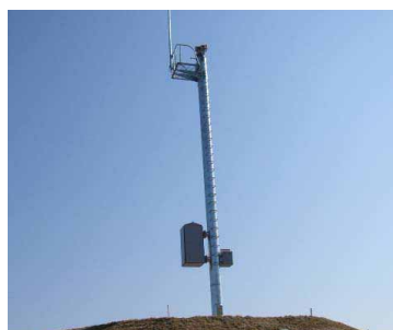
監視用カメラ
