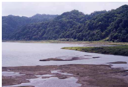
写真1-2-9 にぶたに湖右岸 (貯砂ダム下流)
