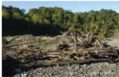
(写真3-8) 膨大な土砂と流木の発生が続く平取ダム上流域の様子 (2005. 9. 28 宿主別川) 河道には多量の流木が堆積し、大雨のたびに移動している。
