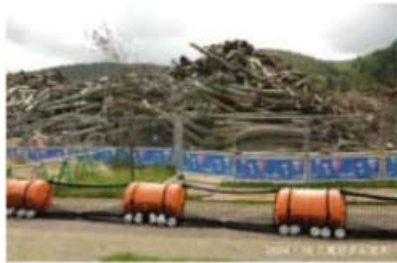
(写真3-7) 二風谷ダムの湖面から回収された流木の山と、流木防止用ネット (2004. 7. 16) 流木防止ネットの高さは1.4mしかなく、大きな流木はくぐり抜けてしまう。また水面下の流木には無力。膨大な流木を、このような施設で止めることには無理がある。
