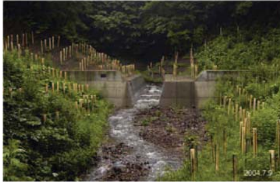
(写真4-2) 切り込みを入れた治山ダムの例（戸切地川上磯ダム上流）
