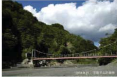
(写真 3-3) 平取ダム堤体計画地 (2004. 8. 25)
