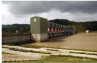
(写真 3-1) 二風谷ダム堤体付近 (2005. 9. 12)
