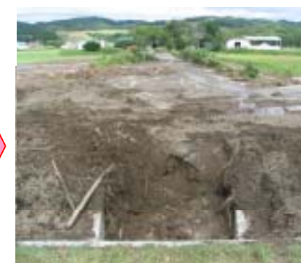
有明2号樋門呑口(オブスケ川)
