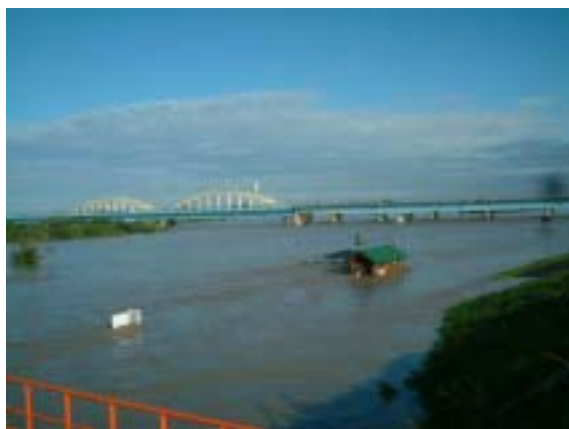
たんぽぽ公園付近の浸水状況
