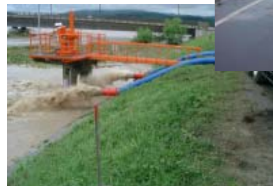
ポンプ車排水状況(穂別1号樋門)
