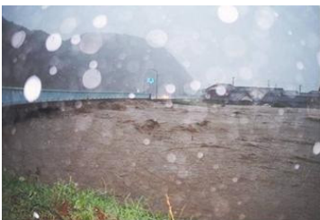
■平成13年9月の豪雨の状況と水位が上昇した宗呂川
