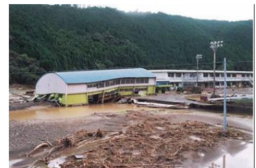
■宗呂川沿いの下川口中学校は、浸水で体育館も被災
