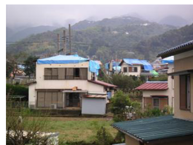
■台風第 22 号による伊東市内の被害発生状況
