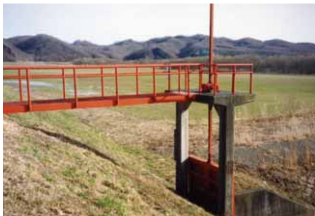
豊城2号樋門(改築前)
