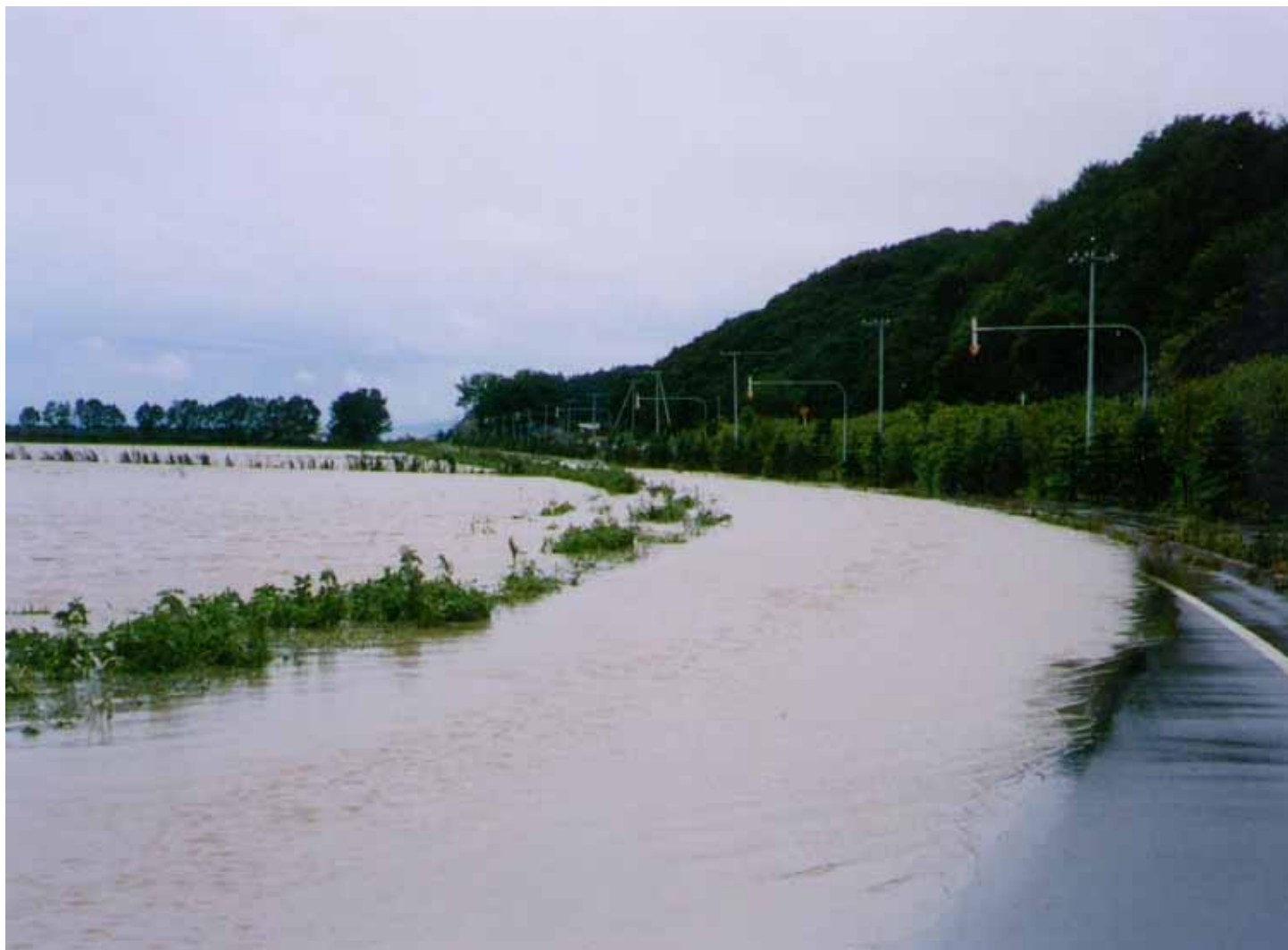
道道米原田浦線冠水
