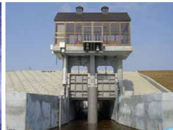
豊城2号樋門(改築後)
