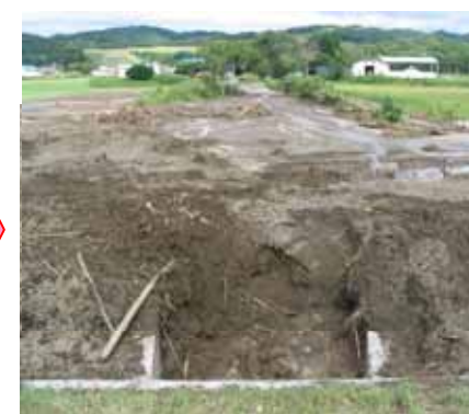
有明2号樋門呑口(オブスケ川)
