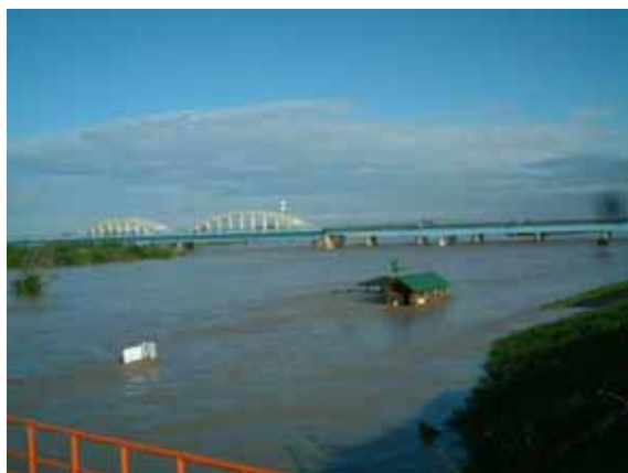
たんぽぽ公園付近の浸水状況
