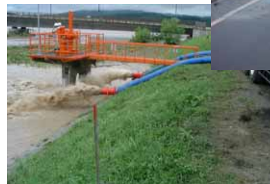
ポンプ車排水状況(穂別1号樋門)
