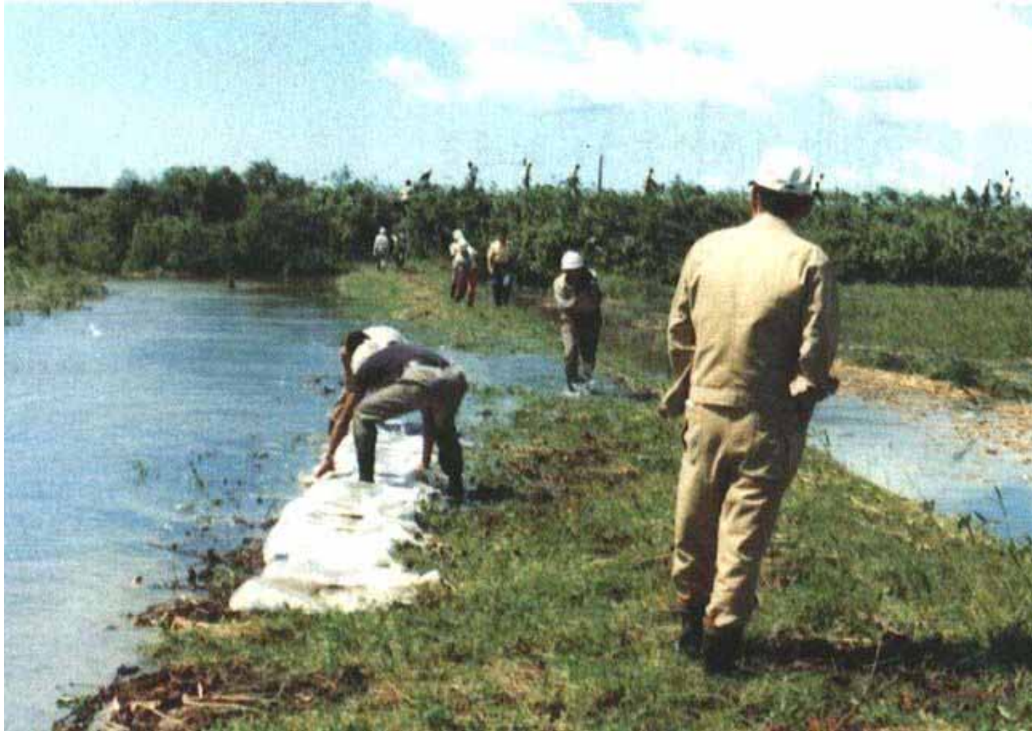
鷓川左支川珍川堤防の応急水防作業
