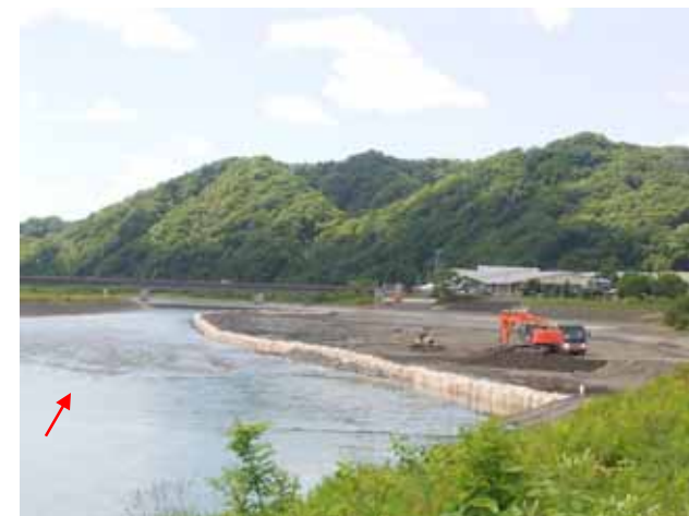
穂別地区河道掘削
