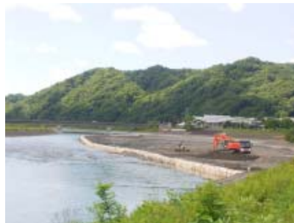
穂別地区河道掘削
