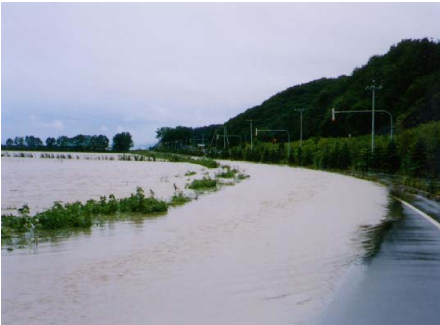
道道米原田浦線冠水
