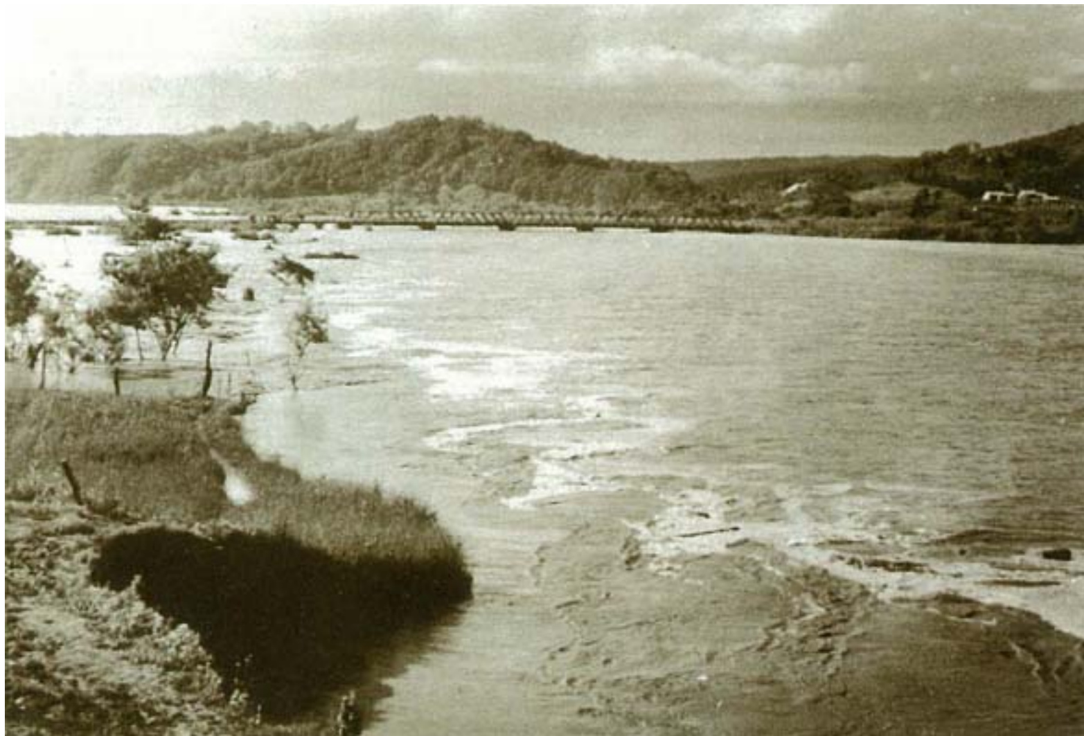
米原地区春日橋取付道路冠水状況
