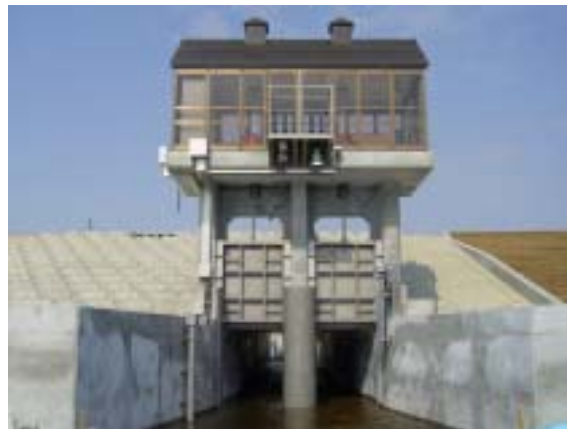
豊城2号樋門(改築後)
