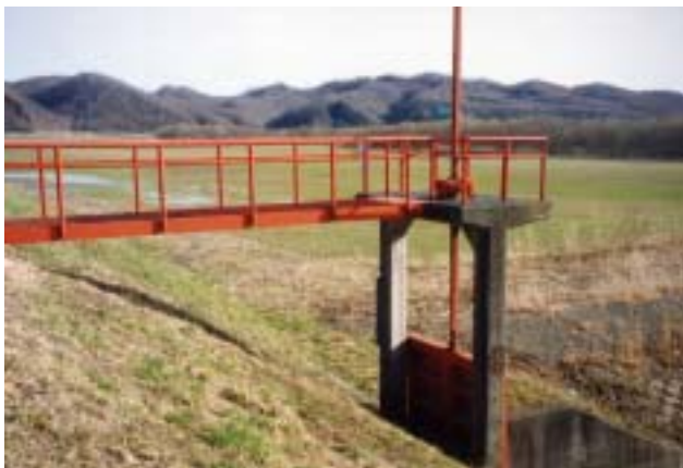
豊城2号樋門(改築前)
