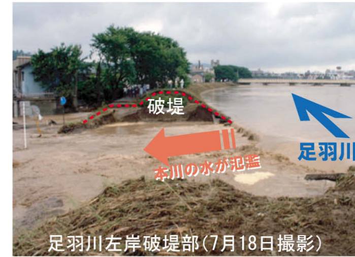
平成16年7月の福井豪雨災害で破堤した九頭竜川水系足羽川堤防の状況
