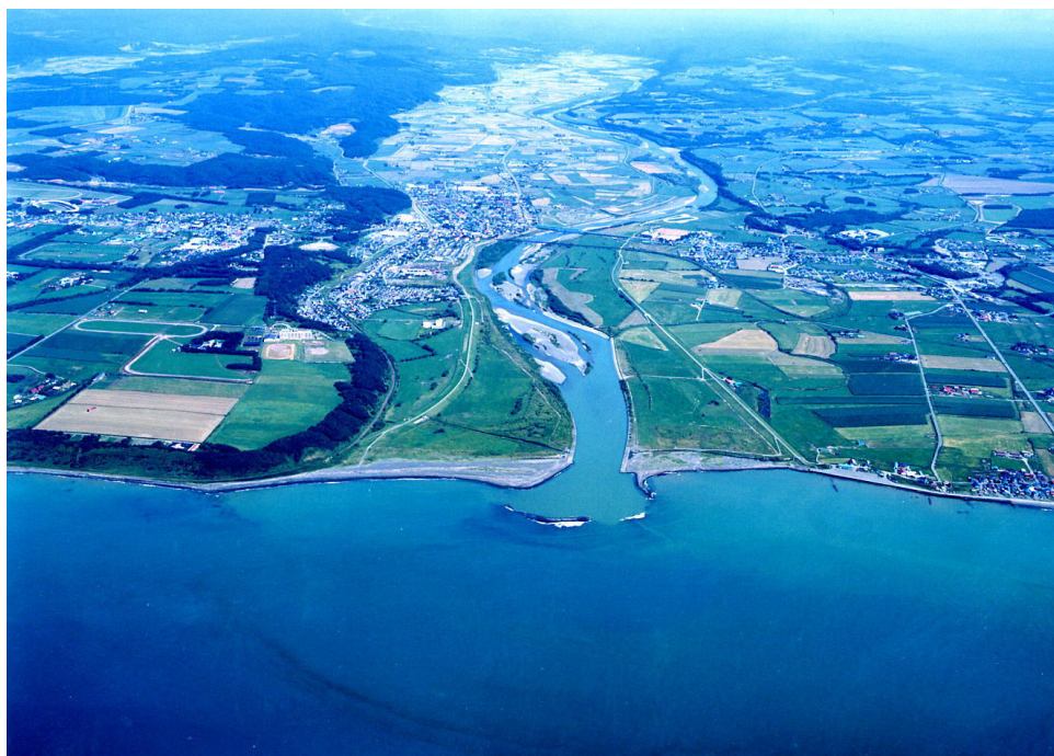
写真 2-3-1 沙流川河口より上流を望む
