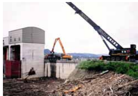
流木撤去状況
