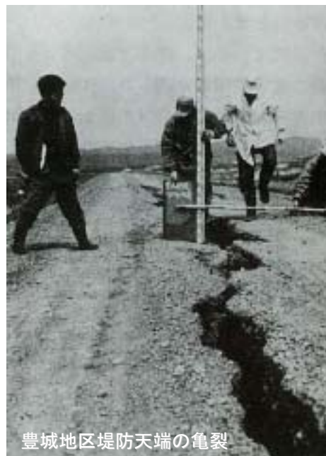
豊城築堤 十勝沖地震における堤防のすべり破壊
