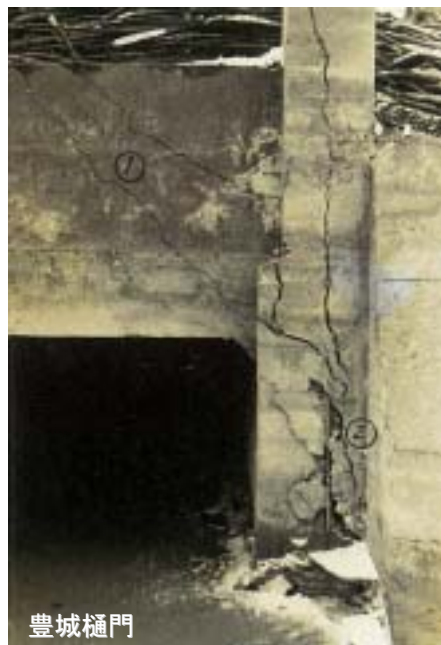
豊城築堤の亀裂
