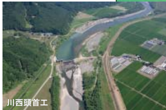
穂別ダム(農業用利水ダム)
