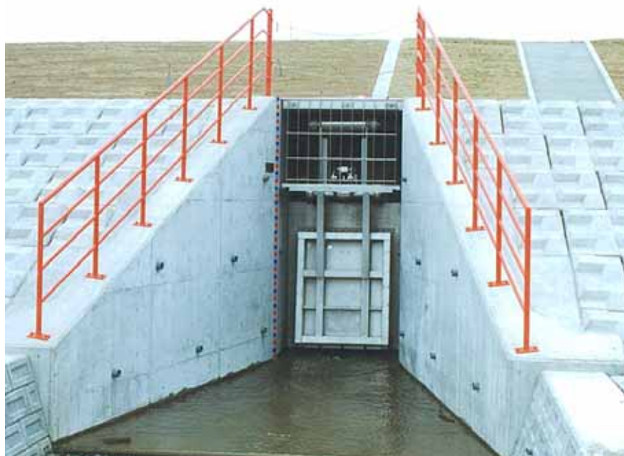
豊城1号樋門(フラップゲート)
