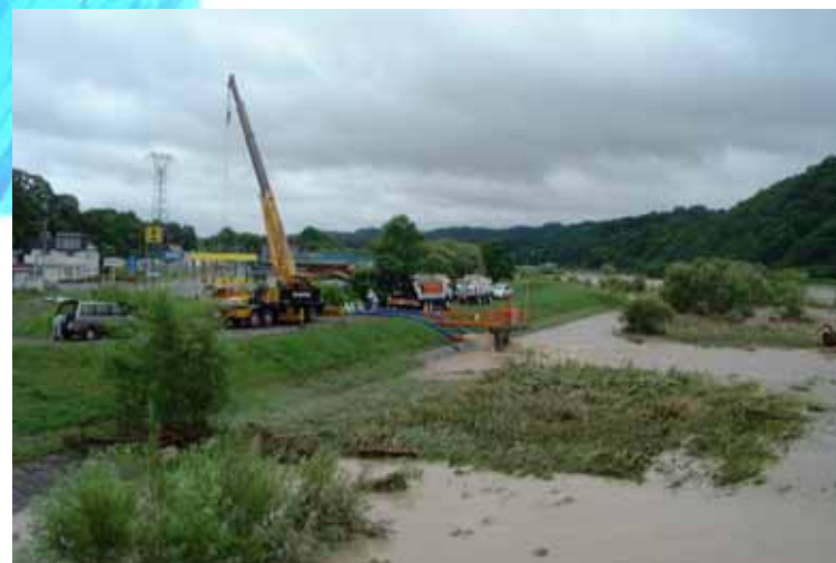
ポンプ車による内水排除の状況 (穂別1号樋門、平成15年8月洪水)
