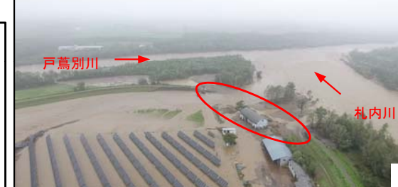
十勝川水系札内川の堤防決壊状況
