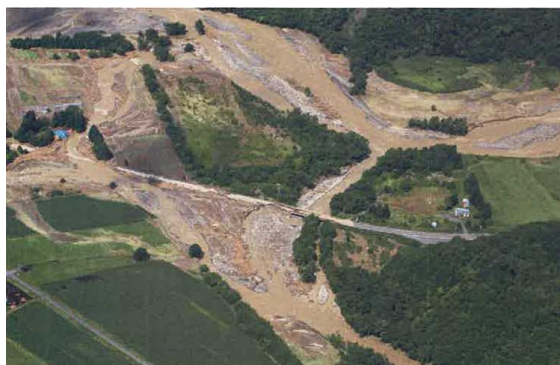
沙流川被災写真（空撮）
