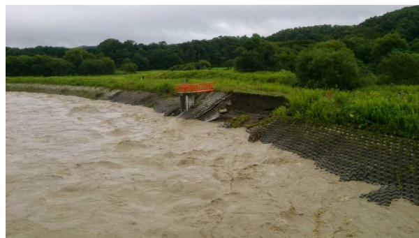
日高門別川被災状況
