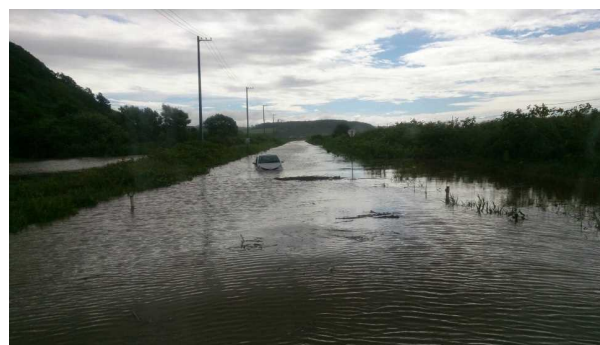
慶能舞川内水氾濫状況
