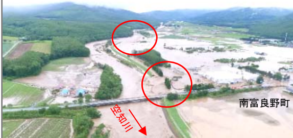
石狩川水系空知川の堤防決壊状況
