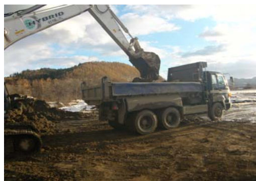
ダンプトラックへ積み込み、
