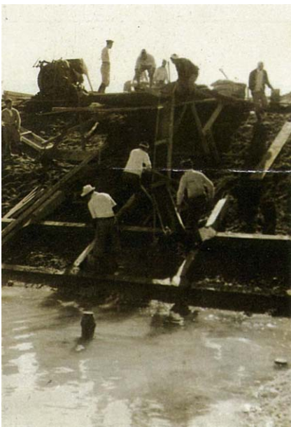
護岸工事(昭和 27 年)
