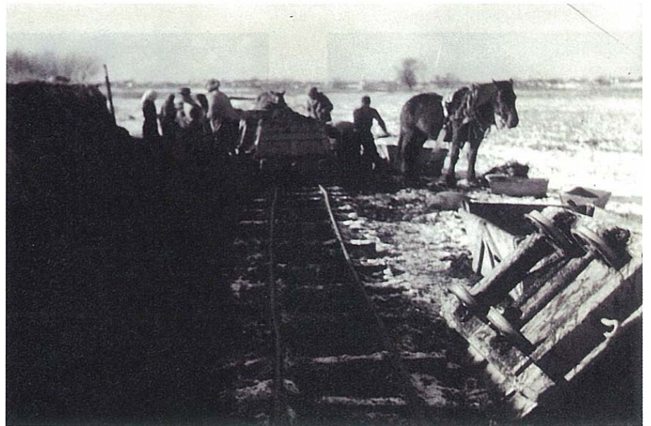
馬トロ口による築堤盛土(豊城築堤)(昭和 26 年)
