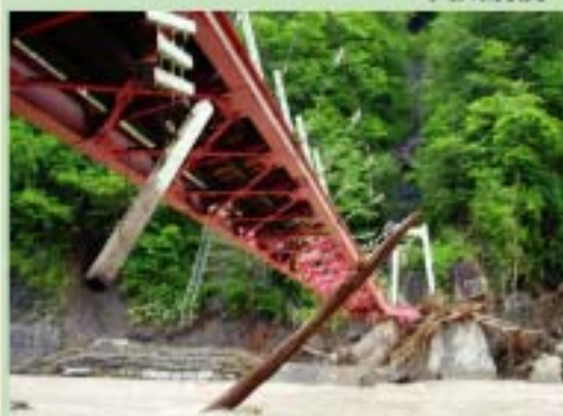
ダムサイト人道橋
