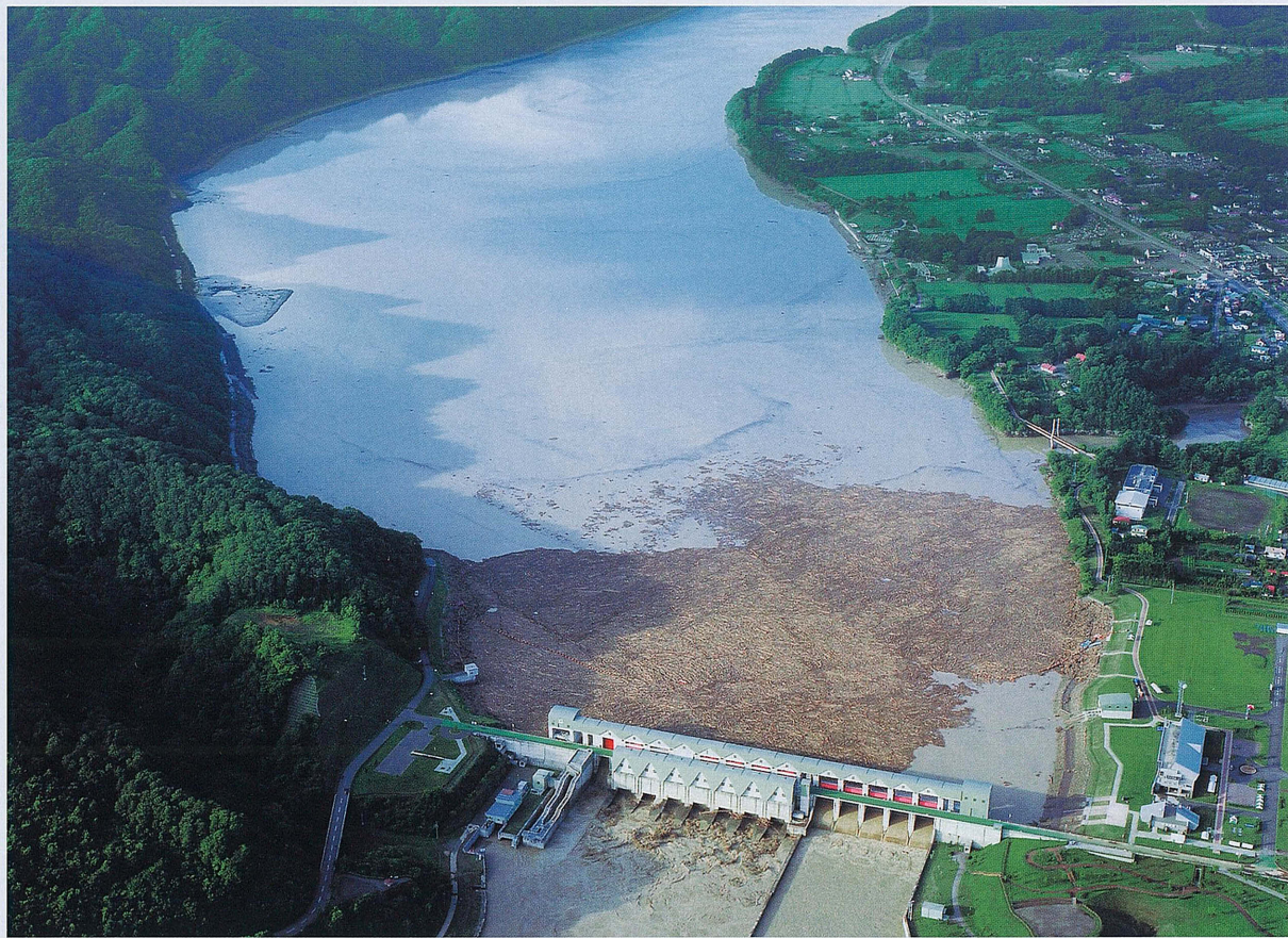
二風谷ダムに捕捉された推定6万7千m 3 (9月5日現在)に及び大量の流木
