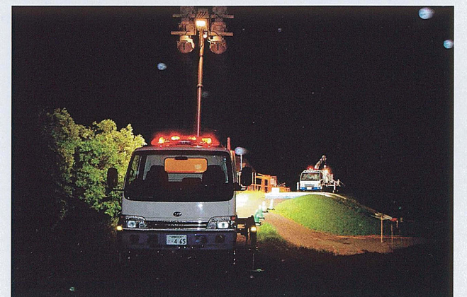
標茶町下オソベツ樋門での夜間照明作業および排水作業
