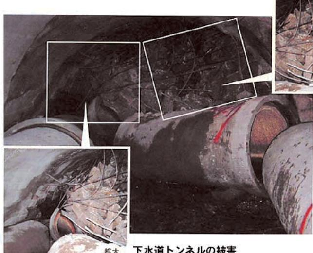
下水道トンネルの被害
