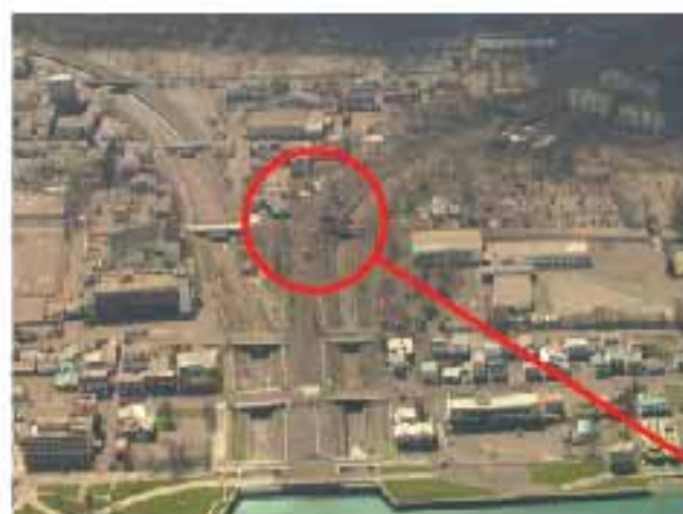
泥流で流された橋
