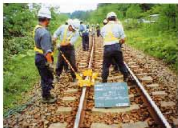
線路の強化工事
