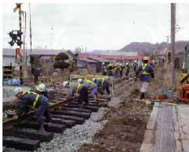
線路の復旧工事
