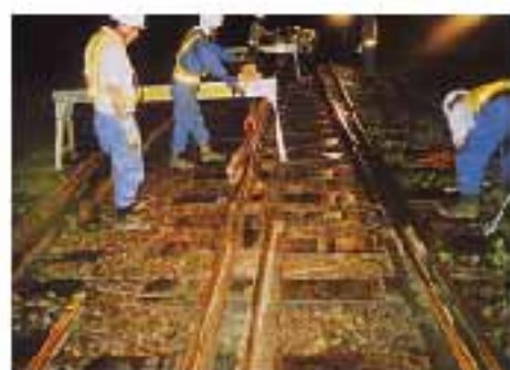
工事は、夜あそくまで行われた
