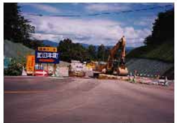
さむらい 道路整備工事の様子
