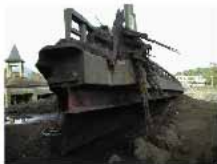
泥流に流された橋
