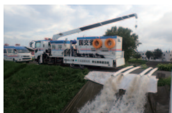
排水ポンプ車による排水支援(帯広市)
