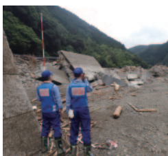
被災状況調査(熊本県八代市)
