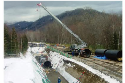
農業用水の安定供給に向けて管の布設作業 (札内川地区 中札内村)
