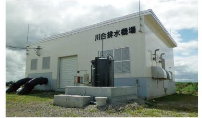
排水機能の安定化に向けて改修した川合排水機場 (川合地区 池田町)
