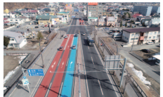
国道241号音更大通(交通安全対策・無電柱化)
