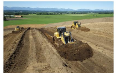
ほ場の大区画化に向けてブルドーザによる切盛土作業 (中鹿追地区 鹿追町)
