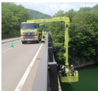
橋梁点検(国道273号泉翠橋)
