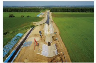
農地の湛水被害解消に向けて排水路を整備中 (士幌西部地区 士幌町)
