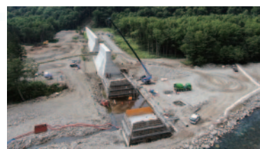
戸蔭別川第4号砂防堰堤(建設中)
