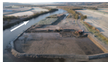
河道掘削(利別川)
