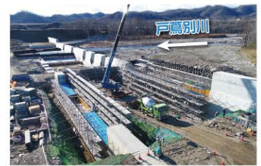
戸鳥別川2号砂防堰堤(平成29年度完成)
