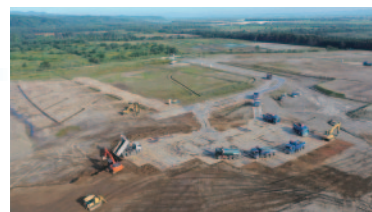
河道掘削土を活用した一時避難場所の造成(豊頃町)
