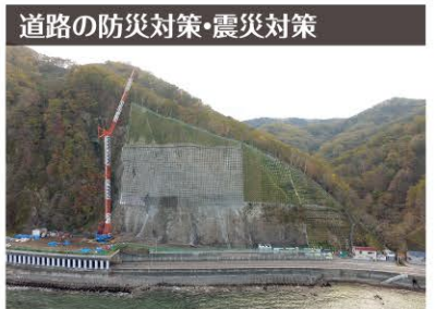
斜面からの落石を防ぐ 国道336号 襟広防災
