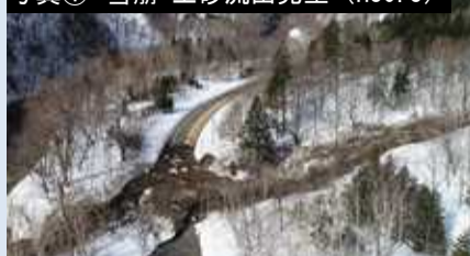
写真① 雪崩・土砂流出発生 (H30.3)
