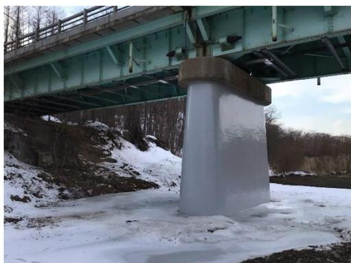
【耐震補強（下部工補強）】
