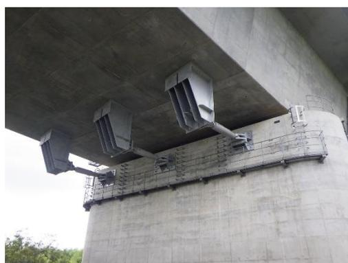
【耐震補強（落橋防止工）】
