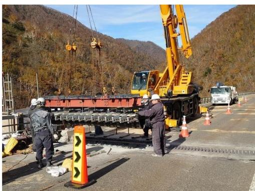
【橋梁補修（伸縮装置取替）】
