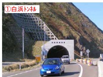
①白浜トンネル H13 白浜トンネル供用により 要対策箇所 3 箇所解消
