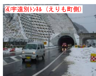
④宇遠別トンネル（えりも町側） H16 年度宇遠別トンネル供用により 要対策箇所 21 箇所解消
