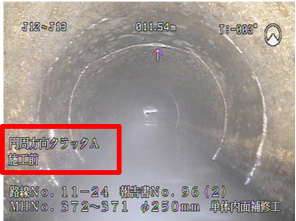
TVカメラによる管内の詳細調査
