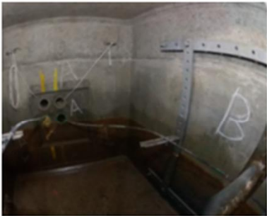
マンホール内写真
