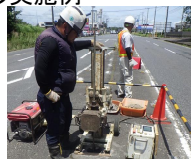
(貫入試験による調査)
