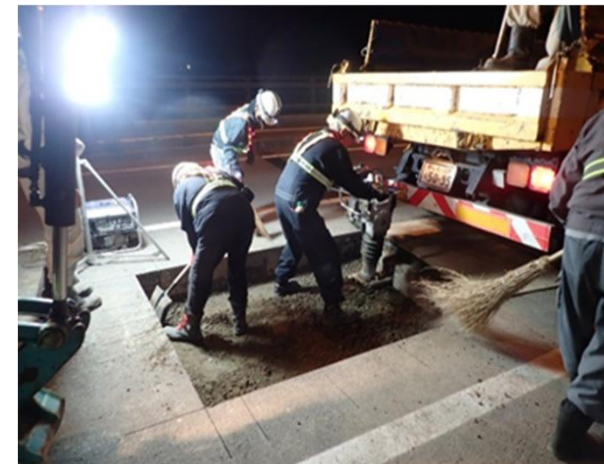
補修状況：国道12号（札幌市）
