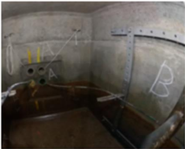
マンホール内写真
