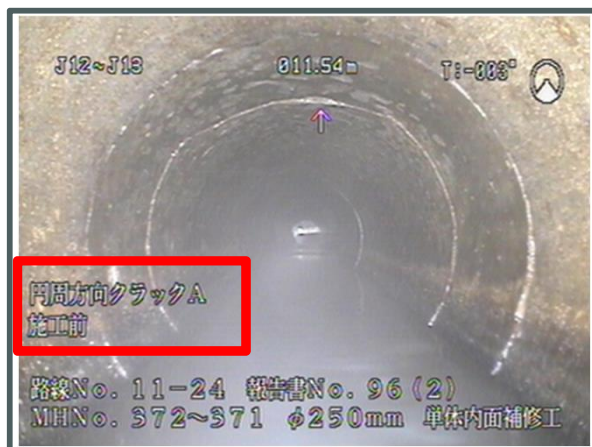
TVカメラによる管内の詳細調査
