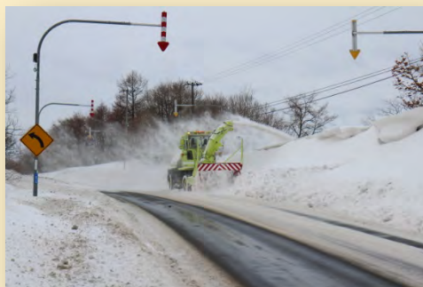
2月19日、国道272号線を作業するロータリ除雪車。
