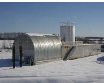
* バイオガスプラント
