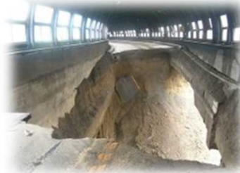
●被災した覆道
