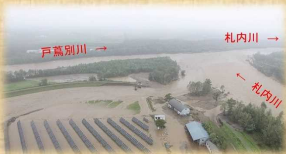
札内川 破堤の様子
