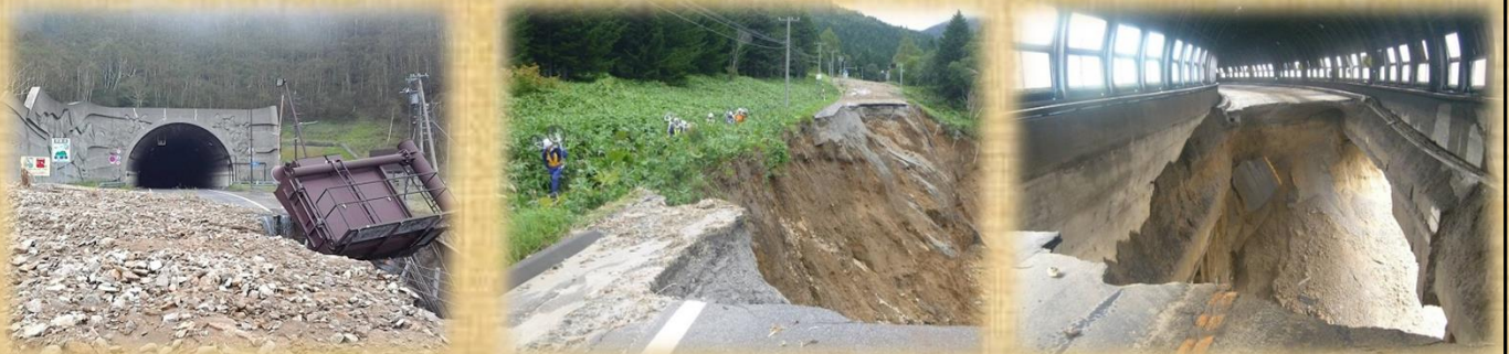
台風後に判明した日勝峠の被害
