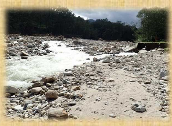
被災後の石山頭首工
