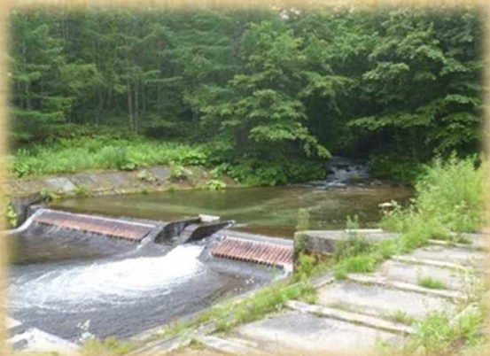
被災前の石山頭首工
