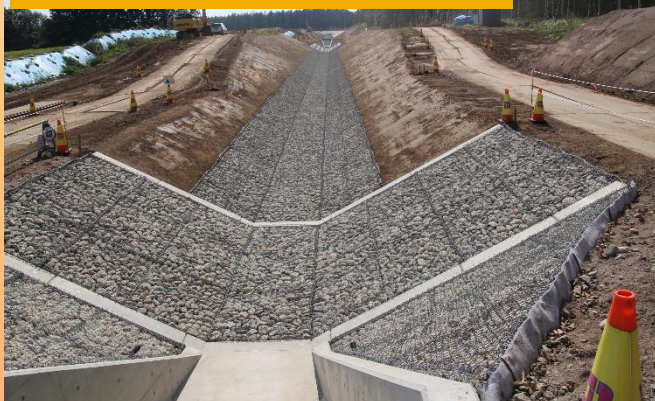
「士幌西部地区」の排水路工事現場見学
