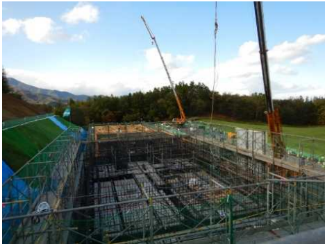
「帯広かわにし導水路八千代西二線工区工事」 「南かわにしファームボンド外一連工事」（隣接） 美生ダムから農地に農業用水を引く「導水路」と、導水した用水を貯めておく調整池「ファームボンド」を建設しています。導水してから畑に利用するまでの時間差を調整でき、農作物の安定生産に貢献します。
