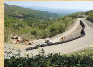
盛土工を実施中 (帯広側日勝峠7合目 6月14日)
