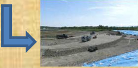
同現場における盛土工の様子 (平成29年5月31日)
