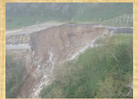
被災状況全景(帯広側日勝峠7合目)
