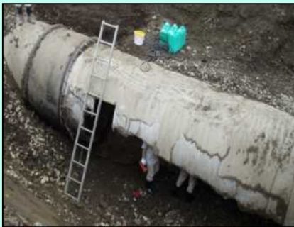
管の破損
