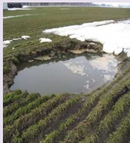
管路の破損事故による農地の陥没
