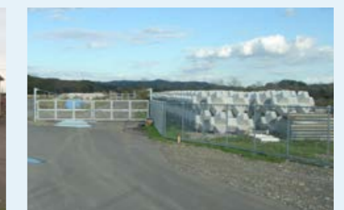
水防資材の備蓄(根固めブロック)
