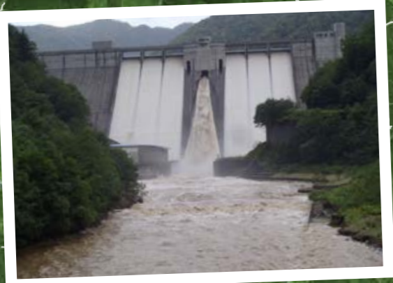
平成28年洪水時の非常洪水吐越流状況
