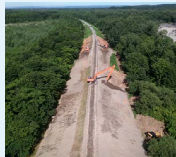
堤防工事の様子
