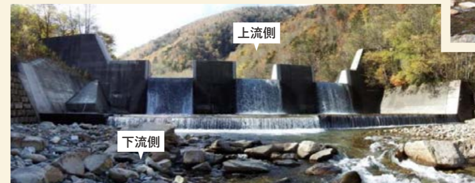
戸蔭別川第6号砂防堰堤
