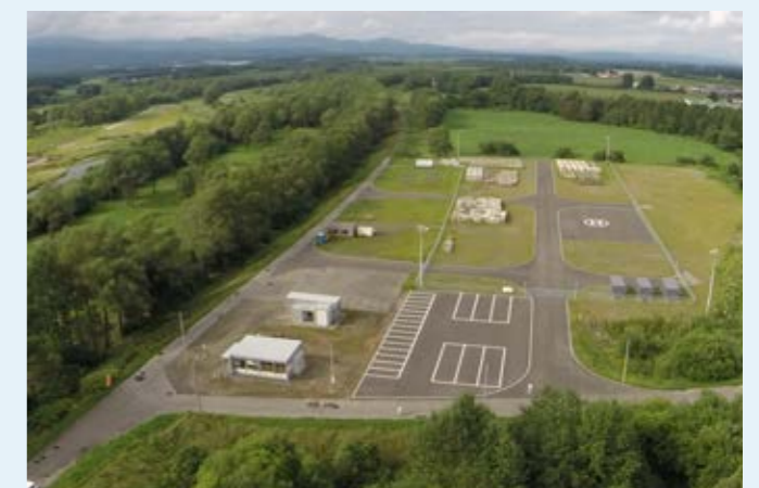
土幌水防拠点
