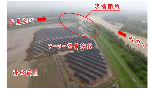
H28札内川の戸蓋別川合流付近堤防決壊状況 (KP24.8左岸付近)
