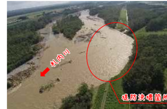
H28札内川の堤防決壊状況 (KP40.8左岸付近)
