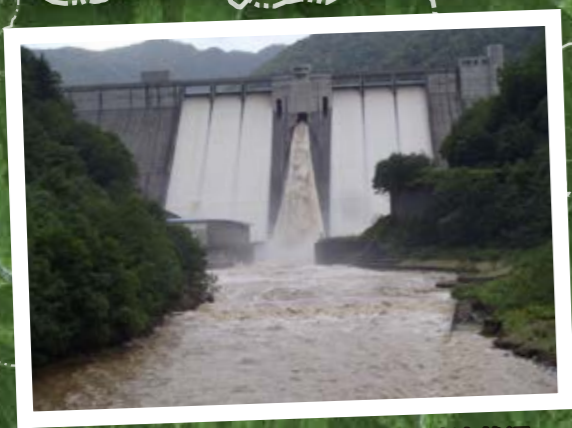
平成28年洪水時の非常洪水吐越流状況
