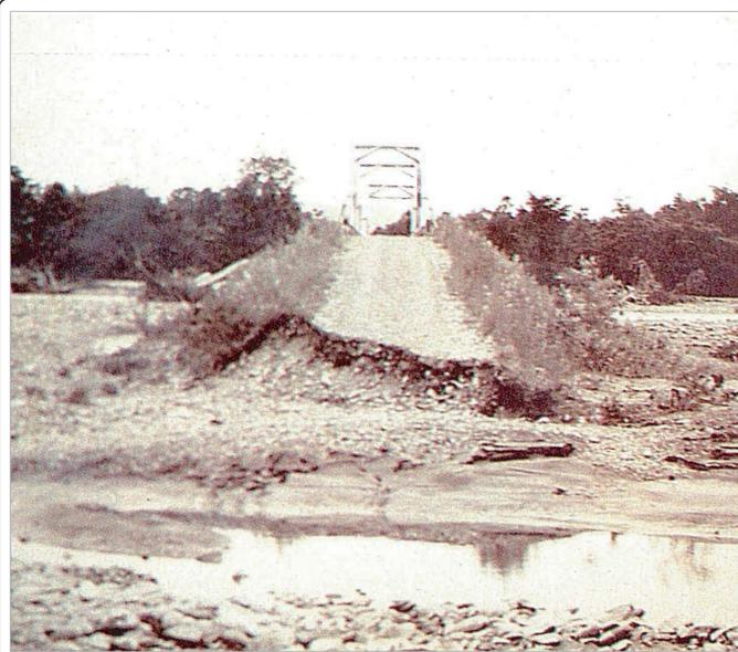
右岸取付道路を洪水で洗い流された上札内橋
