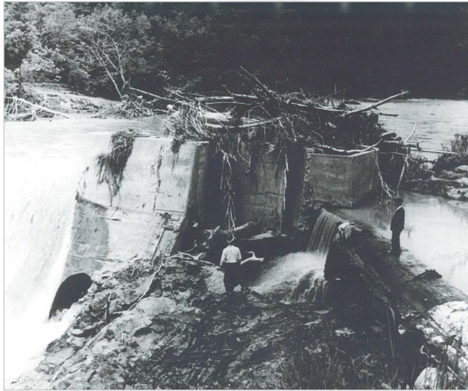
土砂により埋没した農協発電ダム
