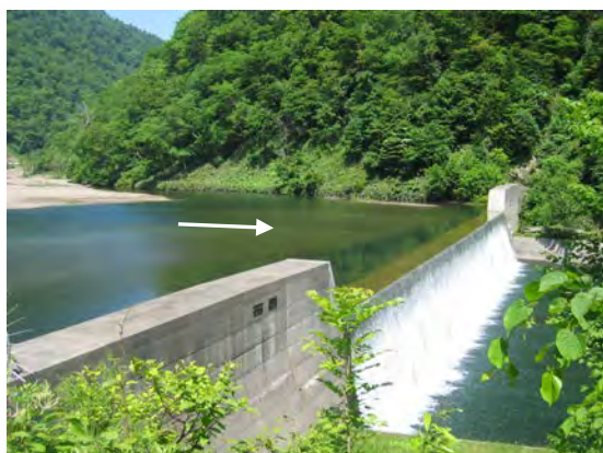
写真1-4 札内川12号えん堤
