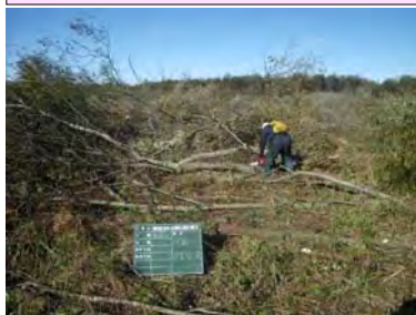
人力での河道内樹木伐開状況
