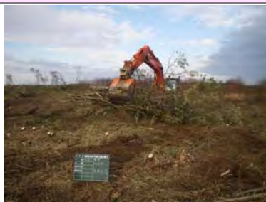
重機での河道内樹木伐開状況
