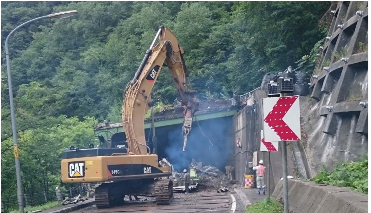
損傷した道路附属物撤去作業状況（20日 午後3時 時点）
