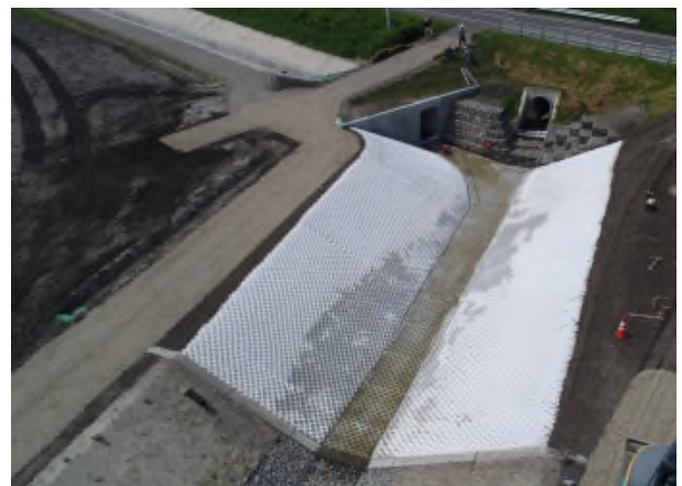
整備中の明渠排水路（士幌西部地区）
