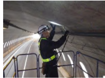
覆道の点検状況 (R273 三国峠覆道)
