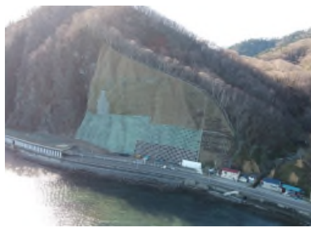
道路斜面の防災対策(R336 襟広防災)
