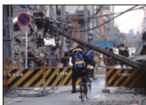
電柱の倒壊による道路閉塞*
