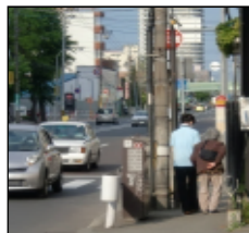
歩行等の支障となる電柱
