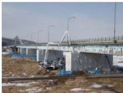
橋脚 RC 巻立による耐震補強 (R38 豊頃大橋)
