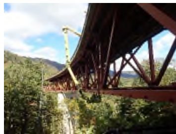
橋梁の点検状況 (R273 松見大橋)
