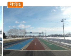
【追突事故多発交差点における滑り止め・カラー舗装の例】 (R38 清水町)
