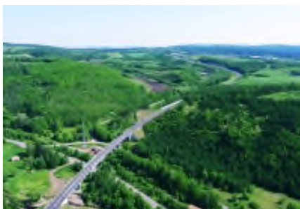
代替性確保のための高規格幹線道路の整備 (北海道横断自動車道)
