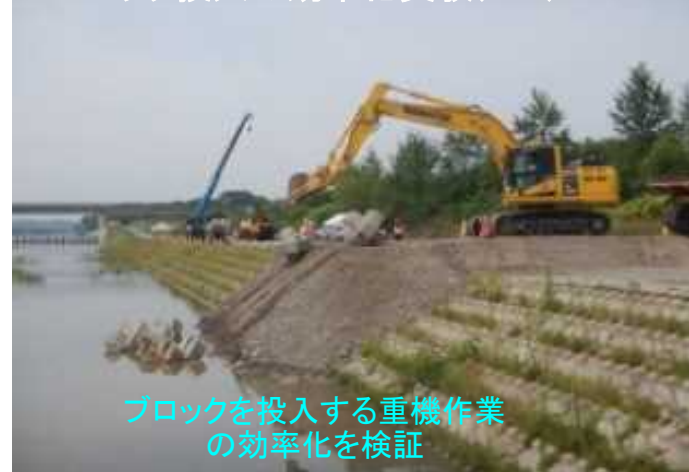
■ブロック投入の効率化実験(H29)
