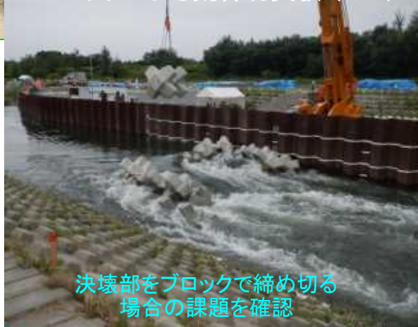
■ブロックによる荒締切実験 (H27)
