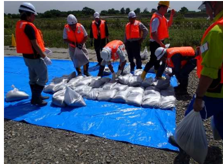
改良積土のう工
