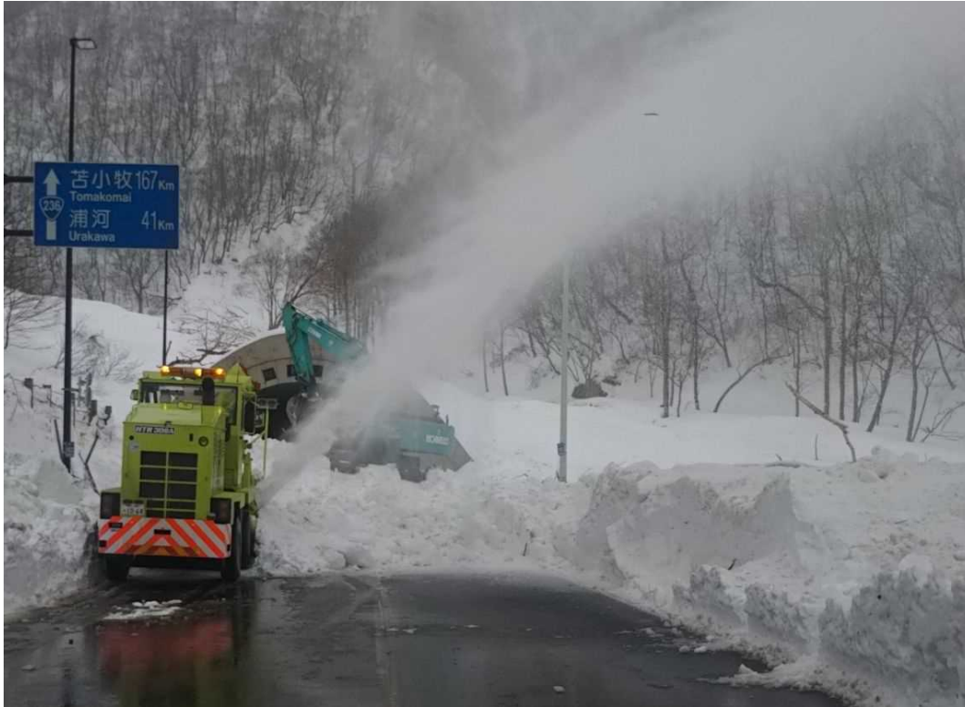
■ 雪崩除去状況
