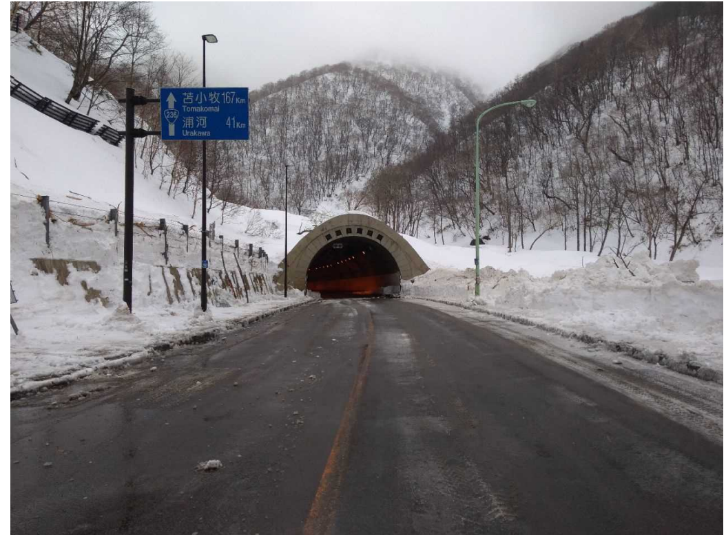
■ 除雪完了状況
